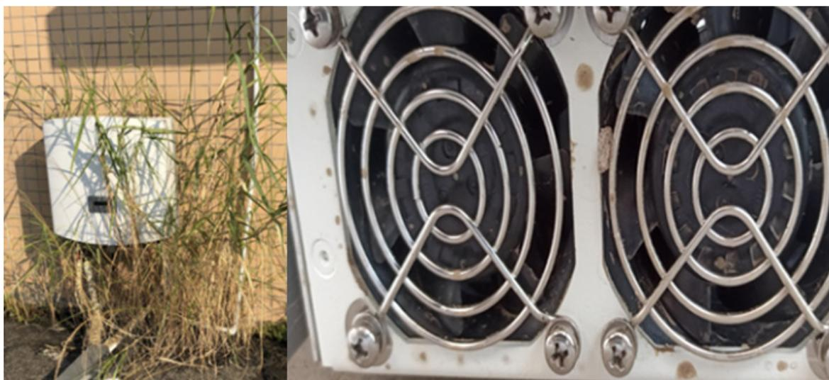
**Lösung:** Beseitigen Sie alle Verunreinigungen um den Wechselrichter herum und prüfen Sie, ob sich Fremdkörper im Lüfter und im Lüftungsschacht befinden, reinigen Sie diese umgehend und testen Sie (wie unten beschrieben), ob sich der Lüfter nach der Reinigung gut drehen lässt. Wenn der Lüfter beschädigt ist, tauschen Sie ihn umgehend aus.
