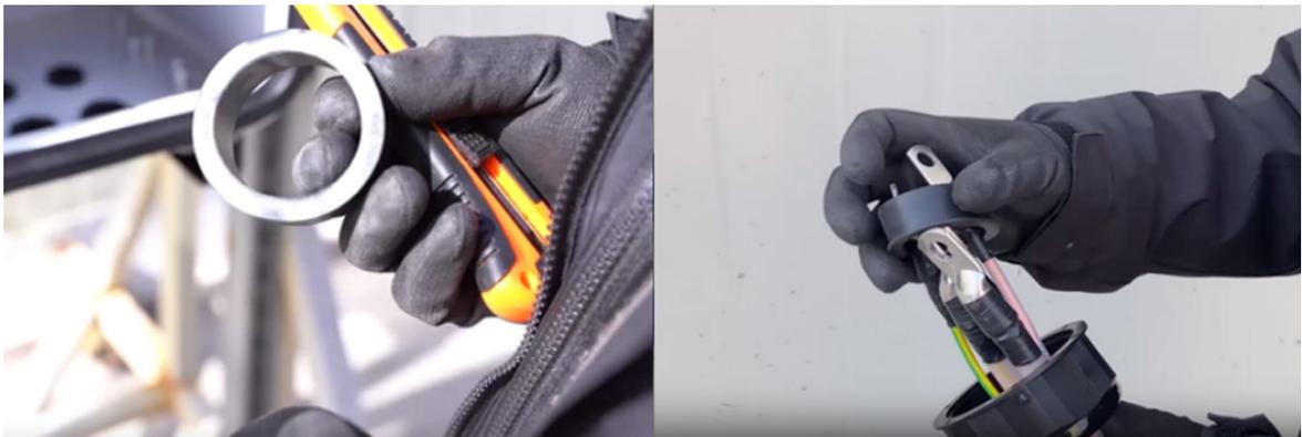
② **Der Durchmesser des AC-Kabels muss den Anforderungen entsprechen. Eine zu lange Ummantelung, ein zu großer Beschnitt des Dichtungsringes usw. behindern den Sitz der Dichtungshülle auf dem Kabel und führen zu einer schlechten Luftdichtigkeit.**
