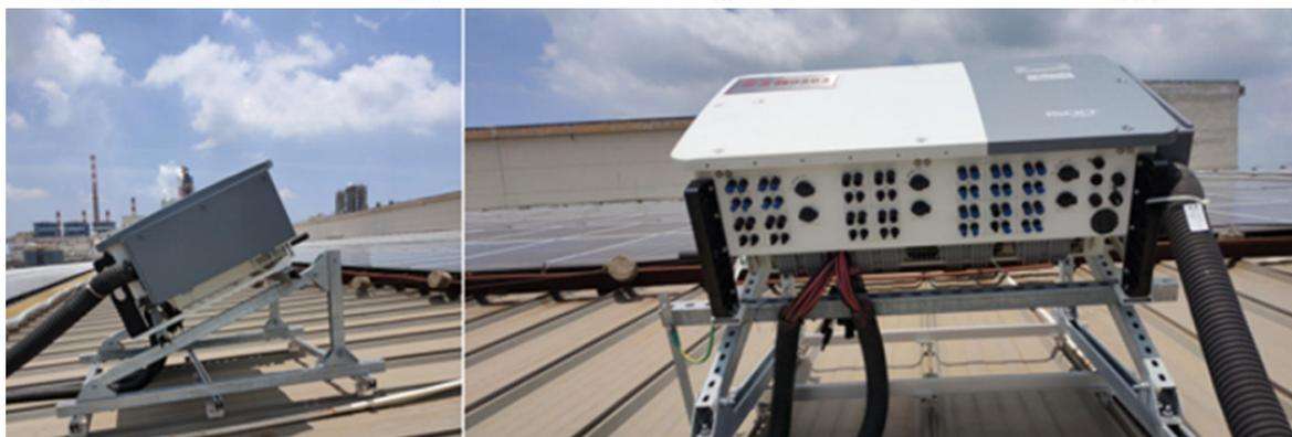
**Beispiel:** Regenwasser gelangt durch die DC-Schnittstelle in das Gerät.
