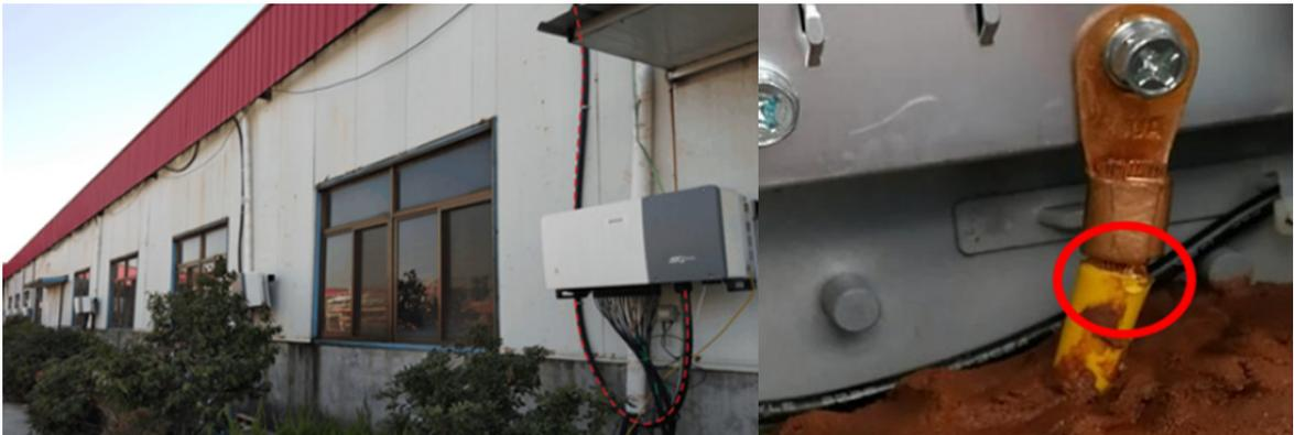
**Lösung:** Schaffen Sie einen Spalt am Boden des Gehäuses, damit Regenwasser abfließen kann. Alternativ positionieren Sie den Muffenanschluss außerhalb des Kabelschachts, damit kein Wasser in den Wechselrichter eindringen kann. Außerdem muss der Anschluss des Erdungskabels, der mit der AC-Seite des Wechselrichters verbunden ist, mit einem Schrumpfschlauch versehen werden, um zu verhindern, dass Regenwasser durch den Erdungskabelanschluss in den Wechselrichter eindringt.
