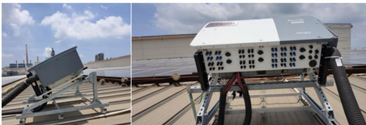
**Esempio:** L'acqua piovana entra nell'apparecchiatura attraverso l'interfaccia DC
