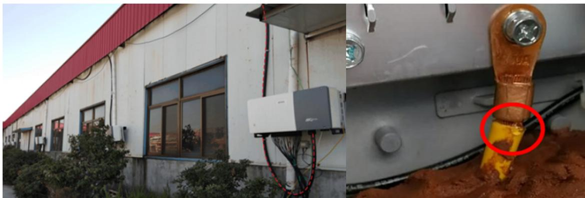
**Soluzione:** Creare una fessura sul fondo dell'involucro, in modo da far defluire l'acqua piovana. In alternativa, posizionare la porta del manicotto all'esterno dell'alloggiamento dei cavi, impedendo all'acqua di entrare nell'inverter. Inoltre, il terminale del cavo di terra collegato al lato AC dell'inverter deve essere trattato con una guaina termorestringente per evitare che l'acqua piovana entri nell'inverter attraverso il manicotto del cavo di terra.
