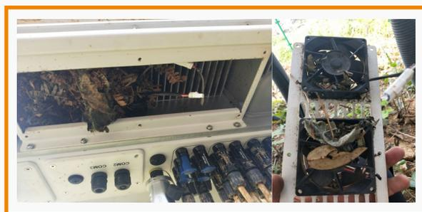
Abbildung 1: Die Ansammlung von Laub blockiert die Luftkanäle und Lüfter
