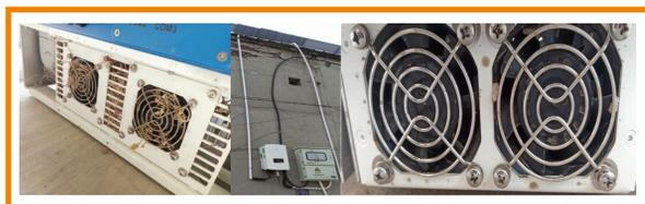
Figura 3: Los desechos bloquean los conductos de aire y los ventiladores del inversor, lo que provoca la falla del inversor.
