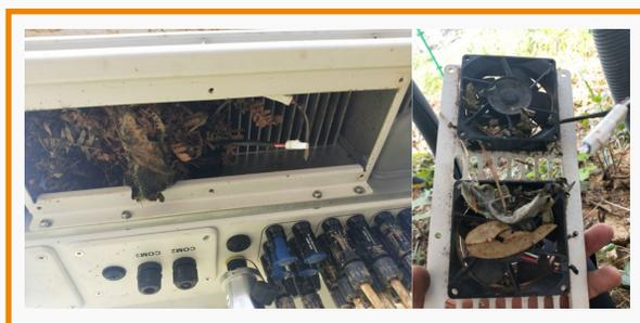
Figura 1: La acumulación de hojas caídas bloquea los conductos de aire de refrigeración y los ventiladores.
