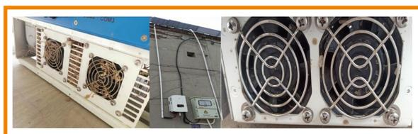
Figura 3: I detriti bloccano i condotti dell'aria e le ventole dell'inverter, causando un guasto all'inverter stesso.
